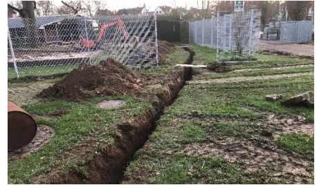
Der Wasserrohrbruch machte viel Arbeit!
